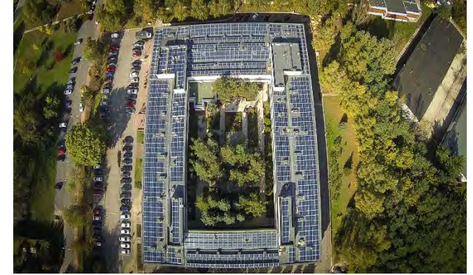
Bildquelle: IBC Solar 2014, Krankenhaus Lodz
