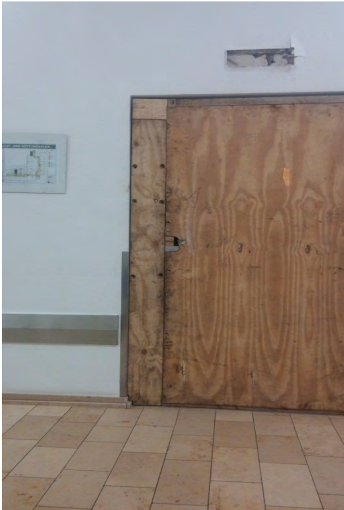
Ehemaliger Fahrstuhlschacht über 4 Etagen, Foto aus EG
