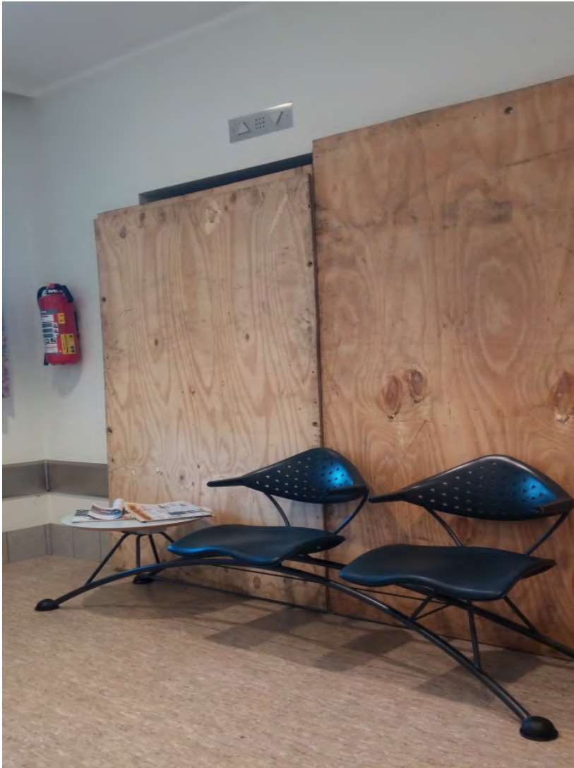
Teil 2, Brandschott aus Rauspund für entkernten Aufzugsschacht von UG bis 5.OG
