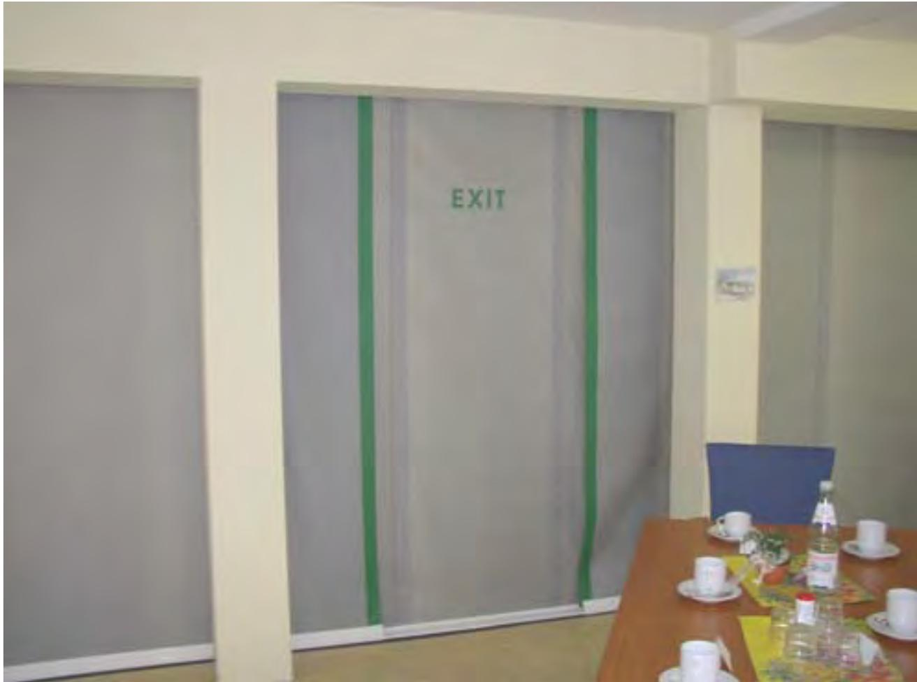
„Berliner Lösung“ – Supercoil mit integrierter Fluchttür
