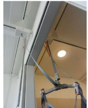
Deckenliftsystem mit Umhängemöglichkeit des Lifertuches am Türsturz
