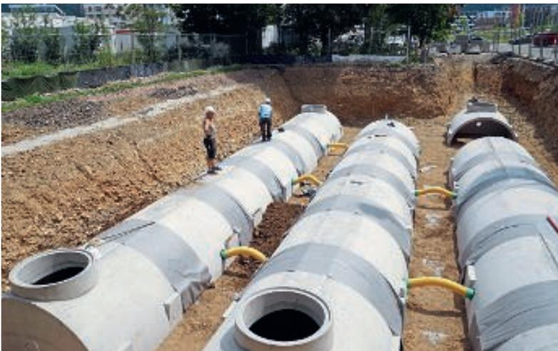
Mit Hilfe von Versickerungsschächten – wie hier neben einer Parkfläche – können Niederschläge gezielt dem Grundwasser zugeführt werden.
