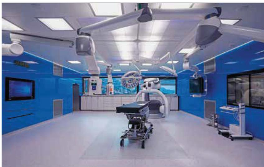
*Dass man Raumaufteilungen mit relativ wenig Aufwand neu gestalten kann, spricht für den Einsatz von Fertigwand- und Deckensystemen.*
